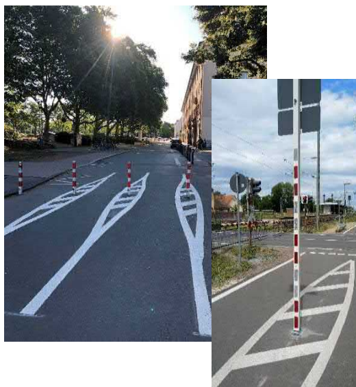
Abbildung: Warnmarkierung Sperrpfosten und reflektierender Mast
