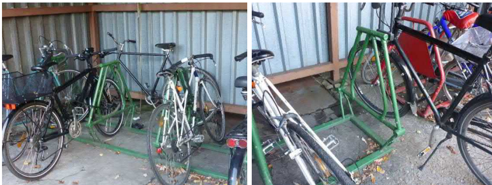
Beispiel selbstgeschweißter Radanlehnbügel, Wilhelmburger Zinnwerke Hamburg (Quelle: Verkehr mit Köpfchen)
