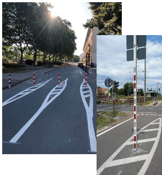
Abbildung: Warnmarkierung Sperrpfosten und reflektierender Mast
