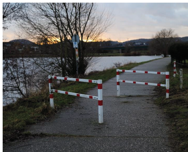
Abbildung: Beispielhafte Umlaufsperrn
