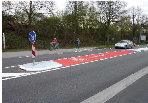
Abbildung: Beispiel einer Überführung Radweg - Fahrbahn in Heppenheim
