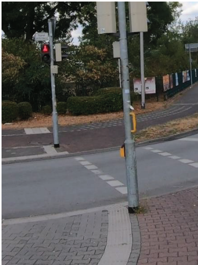
Abbildung 23: Ampelgriff am Knotenpunkt Rugbyring / Haßlocher Straße
