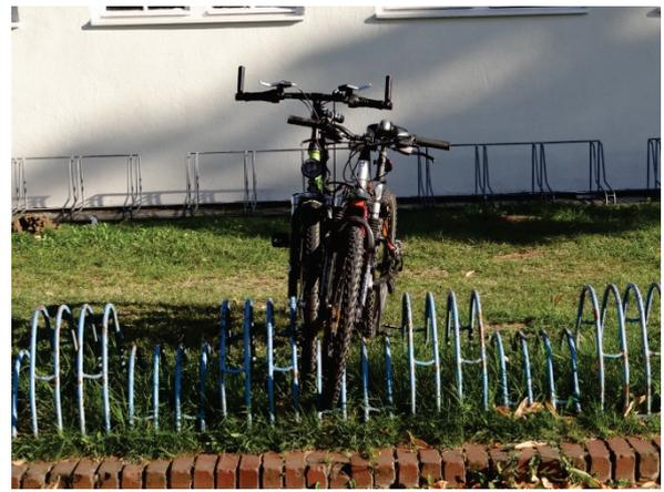
Fahrradparker minderer Qualität, z.T. untauglich ("Felgenkiller", eingeschränkte Sicherung des Fahrrads); Erreichbarkeit über Bord und Ummauerung
