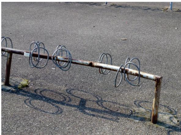
Fahrradparker minderer Qualität ("Felgenkiller", eingeschränkte Sicherung des Fahrrads); marode; keine Überdachung
