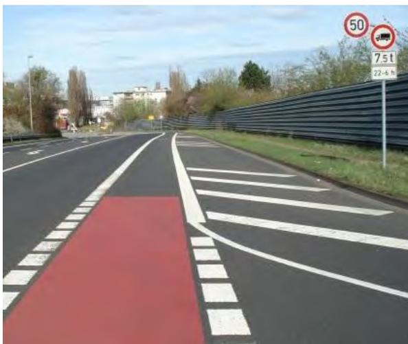
**Abbildung 44:** Diese überbreite Ausfallstraße nach Rüsselsheim wurde durch einen Radfahrstreifen und weitere Markierungen verengt. So wird Tempo 50 eher beachtet.
