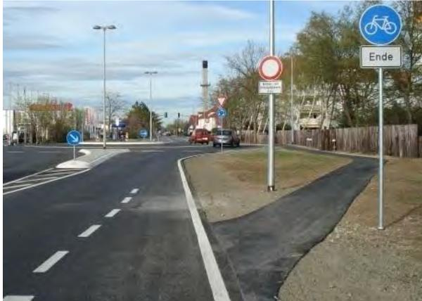
Abbildung 110: Diese Radverkehrsführung vor einem Kreisverkehr in Raunheim ist irreführend.
