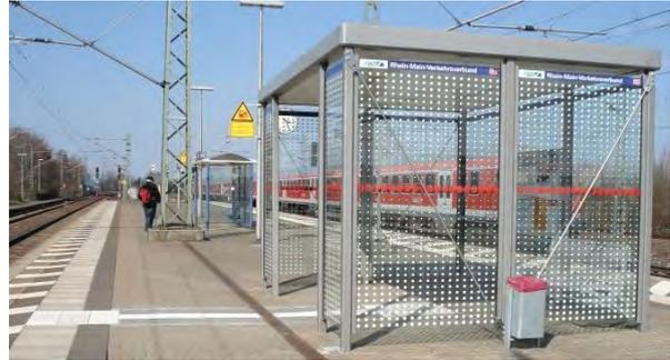
**Abbildung 84:** Blindenleitsystem vom Wetterschutz auf dem Bahnsteig zum Gleis am Bahnhof Dornberg.
