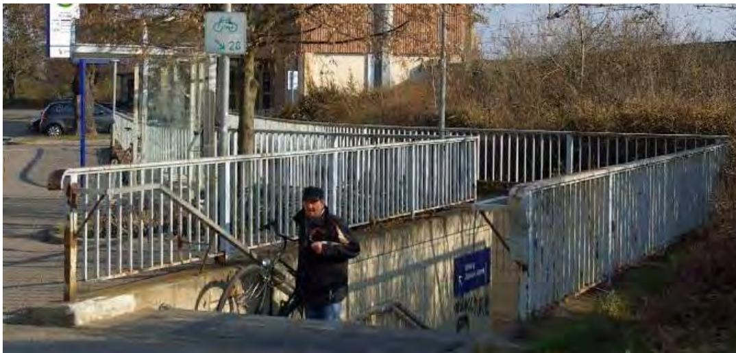
Abbildung 127: Wenig komfortabel für Menschen mit Fahrrad ist diese Treppe mit Schiene zum Hochschieben des Rads (Bahnhof Gernsheim).
