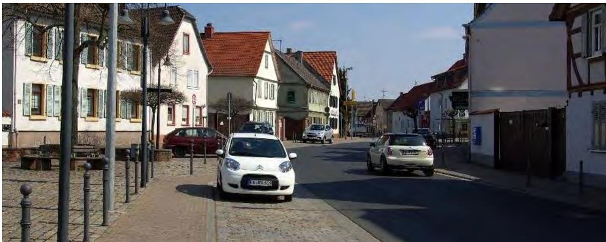
Abbildung 31: Gelungene Straßenraumgestaltung innerorts (Ortsdurchfahrt Trebur): Die Fahrbahnverengung trägt zur Verkehrssicherheit und Aufenthaltsqualität bei, das Parken ist geordnet, für den Fußverkehr gibt es ausreichend Platz. Aufpflasterungen verdeutlichen die Funktionsunterschiede der Flächen.
