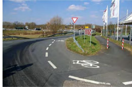
Abbildung 95: An Knotenpunkten wird die Radverkehrsführung häufig unübersichtlich: Von dieser Seite kommend ist die Führung eindeutig, von der anderen Seite kommend nur zu erahnen (Goddelau).
