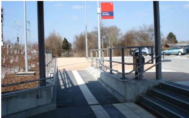
**Abbildung 85:** Am Ostausgang des Bahnhofs Dornberg werden Blinde allerdings in die Irre geleitet: Hier endet das von der Unterführung kommende Leitsystem am Ende der Rampe...
