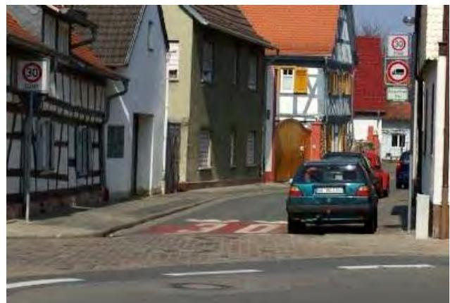
Abbildung 29: Der Beginn von verkehrsberuhigten oder Tempo-30-Zonen wird sinnvollerweise baulich und/oder durch Fahrbahnmarkierungen verdeutlicht (hier in Geinsheim).
