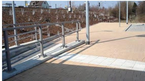
**Abbildung 86:** ... während das zum Parkplatz führende Leitsystem am Geländer an der Seite der Rampe beginnt.
