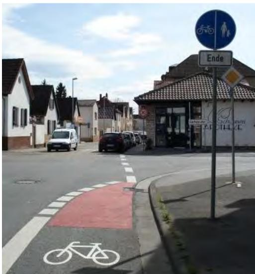
**Abbildung 108:** ...Leider ist das Ende nicht so gelungen wie der Anfang: Diese Markierung kann den Kfz-Verkehr beim Rechtsabbiegen dazu verleiten, den geradeausfahrenden Radverkehr zu schneiden.
