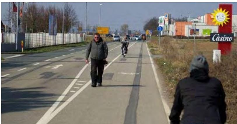
Abbildung 117: Westlich des Bahnhofs Wolfskehlen wird der Rad- und Fußverkehr gemeinsam geführt, baulich nicht getrennt von der Straße. Für Fußgänger ist dies wenig attraktiv und bietet ein geringes Sicherheitsgefühl.
