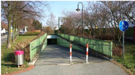
**Abbildung 77:** Diese Rampe am Bahnhof Biebesheim ist in Punkto Barrierefreiheit eine gute Lösung und gleichzeitig komfortabel für Radfahrer.
