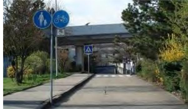
Abbildung 111: Rüsselsheimer Besonderheit sind die querungsarmen, überbreiten Radwege zum Opel-Standort. Nachteil sind die zu bewältigenden, allerdings moderaten Höhenunterschiede durch die Unterführungen.
