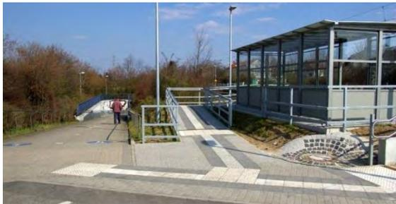
Abbildung 125: Eine breite Unterführung für Fußgänger und Radfahrer mit geringer Steigung sowie barrierefreier Zugang zum Bahnsteig - vorbildliche Sanierung am Bahnhof Wolfskehlen.
